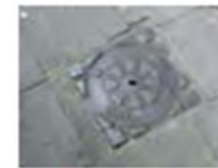
Individueel deksel van het waterleidingnet
