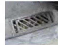
De rioolkolken die het afvloeiende regenwater opvangen
