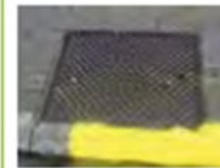
Collectief deksel van het waterleidingnet
