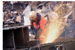
Autogeen snijden(oxycutting)
